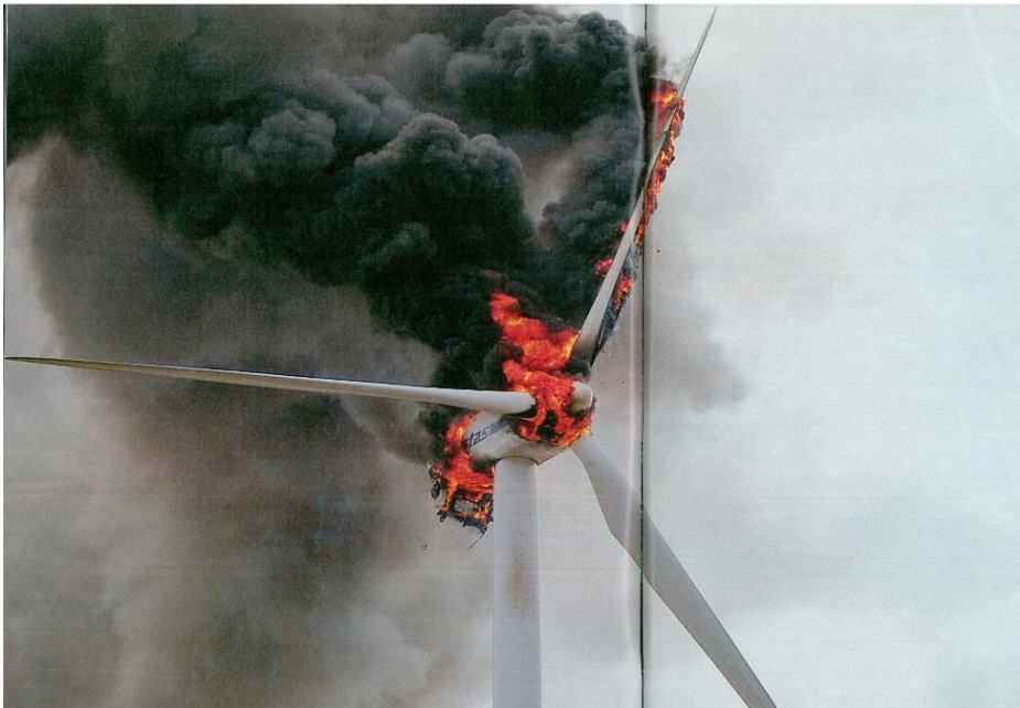
Rys. 18. Typowy wypadek awarii siłowni wiatrowych. Der Spiegel [1, 2, 3].
