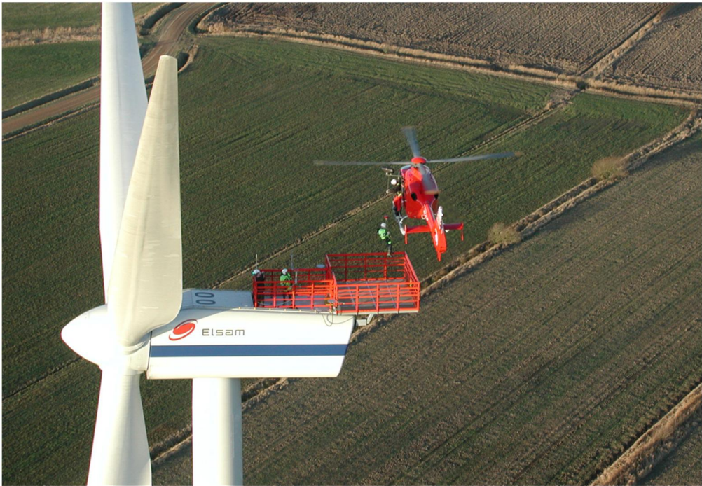
Rys. 19. Dogład techniczny maszynowni przy pomocy helikoptera. Der Spiegel [1, 2, 3].
